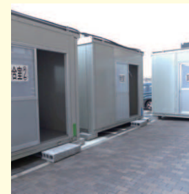
▲待合室2台、診察室を1台設置
