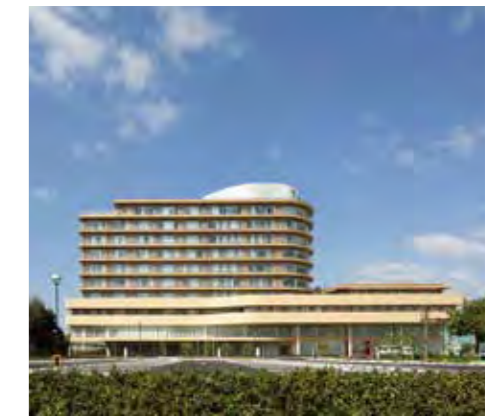
直接日射を遮蔽する全周バルコニーや病室にペアガラス（一部LOW-E）を採用
