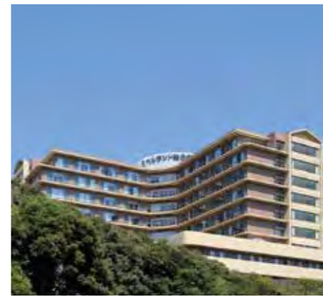
ベルの森からの冷涼な空気を導入し空調熱源負荷を低減。井戸水も利用。
